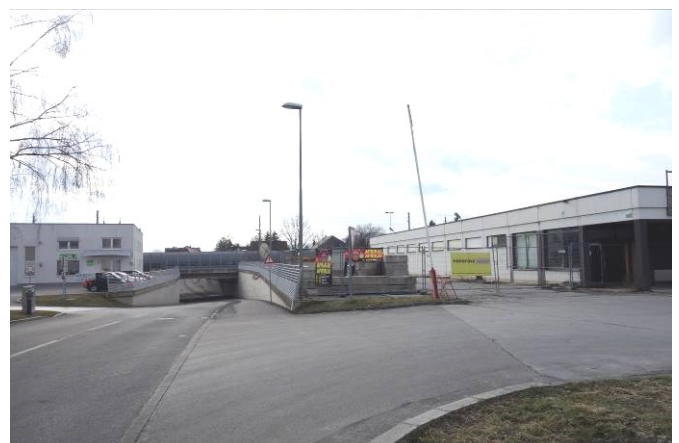
Foto 2: Blick vom südlichen Teil des Grundstücks entlang der Grenzgasse auf die Bahntrasse mit Unterführung Grenzgasse
