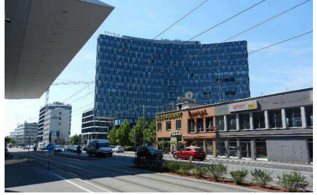
Foto 10: Blick von der Conrad-von-Hötzendorfstraße auf Planungsgebiet in Richtung Südwesten
