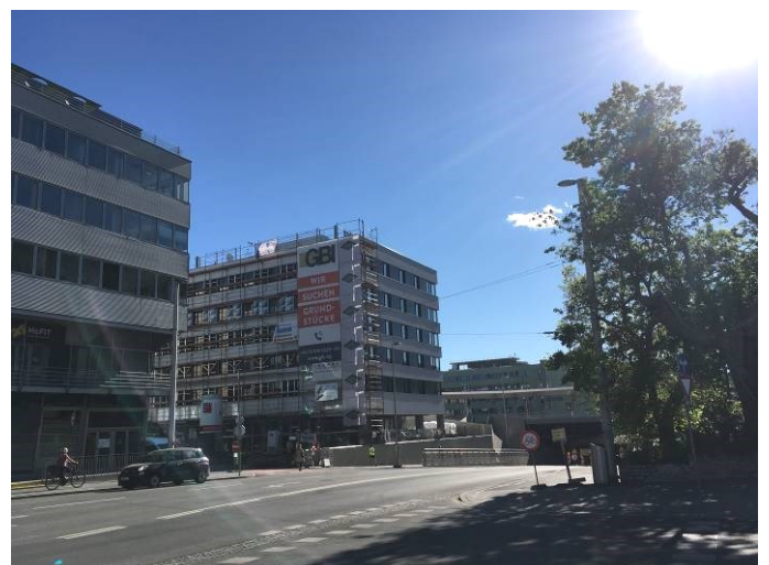
Foto 2: Europaplatz Höhe Hausnr. 1 (Hotel Daniel) Blick in südwestliche Richtung.
