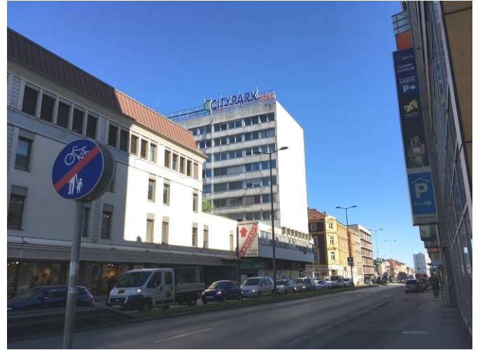
Foto 22: Europaplatz Höhe Hausnr. 20 (Bauamtsgebäude) Ecke Eggenberger Gürtel, Blick in südöstliche Richtung.
