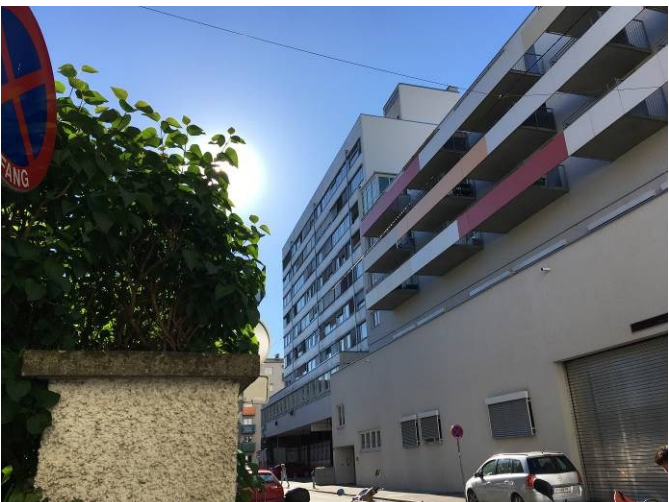
Foto 19: Arnold-Luschin-Gasse Höhe Hausnr. 1 Ecke Traungaugergasse, Blick in nordwestliche Richtung.
