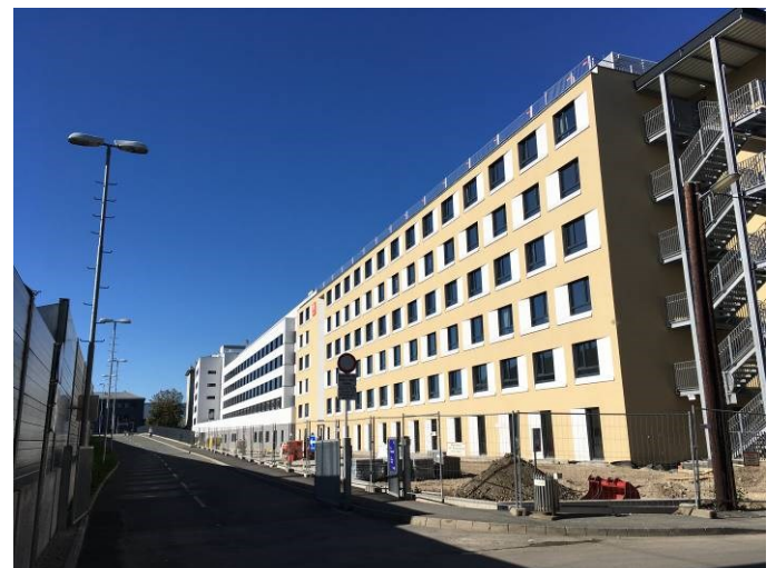
Foto 6: Niesenberggasse Höhe Hausnr. 77 Blick in südwestliche Richtung.
