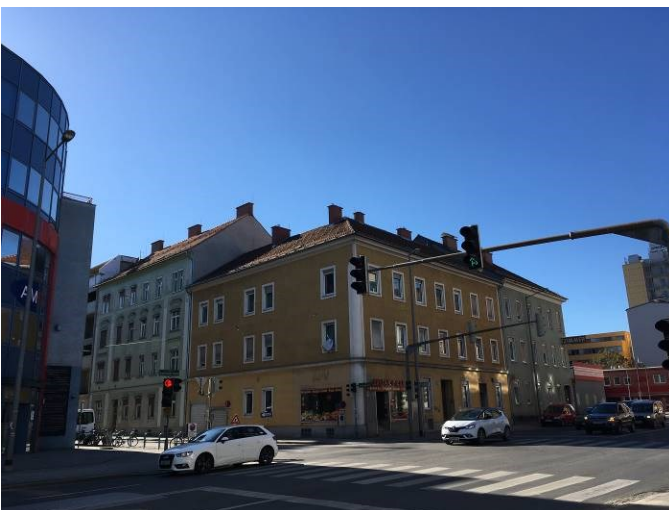
Foto 13: Kreuzungsbereich Eggenberger Gürtel / Niesenberggasse, Blick in nordwestliche Richtung.
