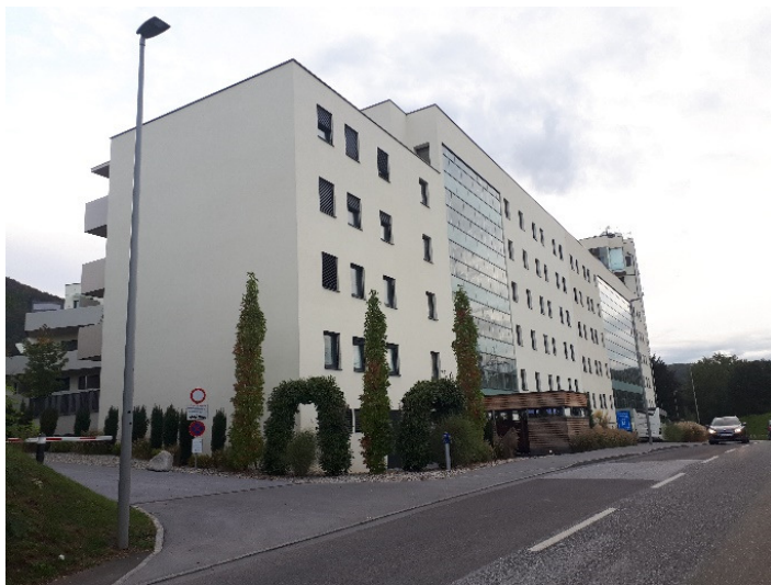
Foto 5 Wohnpark Gösting an der Anton-Kleinoscheg-Straße: Blick Richtung Norden. Links das Planungsgebiet (Baufeld I + II)
