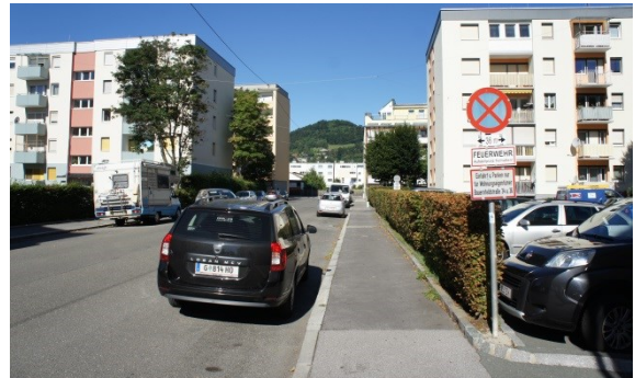
Foto 4: Bauernfeldstraße: Blick Richtung Westen auf die freistehenden fünfgeschossigen Wohnhäuser Bauernfeldstraße 29 und 36.
