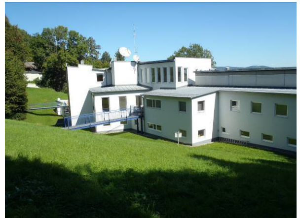
Foto 2: Kastanienhof Blick in nordöstliche Richtung.
