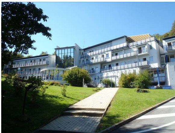
Foto 1 : Kastanienhof Blick in westliche Richtung.
