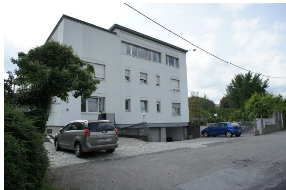
Foto 8: Blick in den Mühlriegel, auf das Haus Mühlriegel 9. Blick Richtung Nordwesten.
