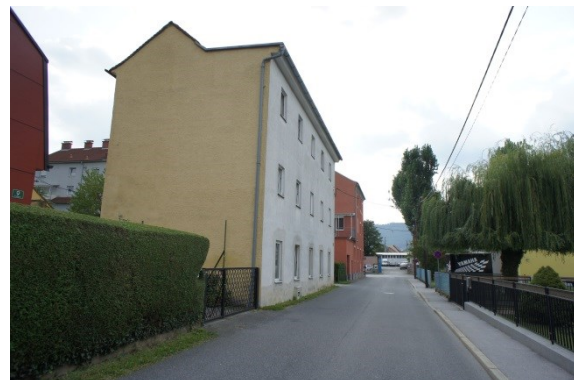
Foto 4: Blick in die Bunsengasse, auf Höhe Bunsengasse 11. Blick Richtung Westen.
