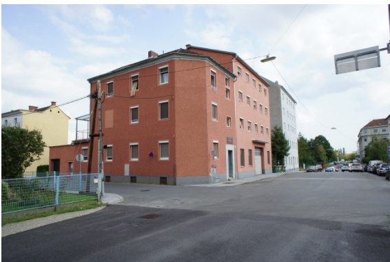
Foto 3: Kreuzung Lastenstraße - Bunsengasse. Blick Richtung Süden.
