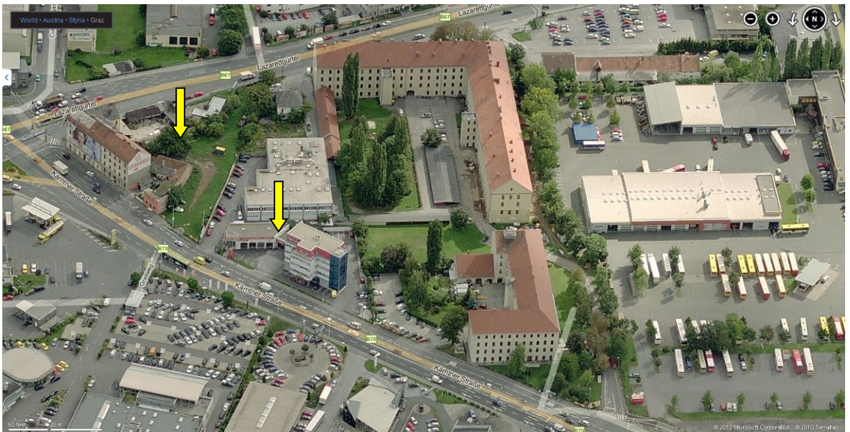
Luftbild/ Schrägaufnahme (2007): Blick in östliche Richtung. Die gelben Pfeile bezeichnen das WB-Areal Bauplatz. Microsoft Company © / Vexcel Imaging GmbH, Graz/Austria
