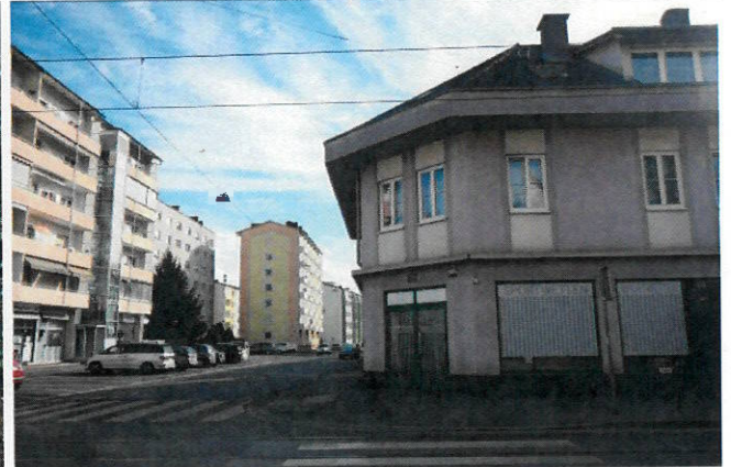
Foto 12: Blick in südliche Richtung in die Vinzenzgasse, rechts bzw. in Bildmitte ist die Bebauung an der Georgigasse 25 zu sehen
