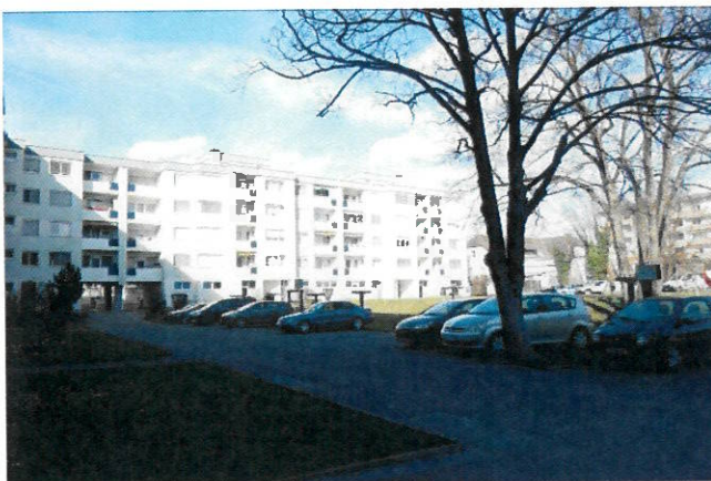
Foto 13: Blick in nordöstliche Richtung vom Innenhof des Bebauungsplangebietes auf die Liegenschaften Georgigasse 27, 29 und 31
