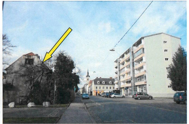
Foto 18: Blick in nördliche Richtung entlang der Vinzenzgasse, links im Bild die Liegenschaft Vinzenzgasse 19 (gelber Pfeil), rechts der sechsgeschossige Baukörper der Liegenschaft Vinzenzgasse 20 und 22
