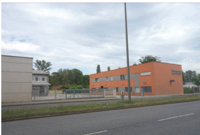
Foto 7: Blick in südöstliche Richtung auf die Liegenschaft Wiener Straße 202 (Polizeigebäude), links im Bild ein Betriebsgelände der AVL an der Wiener Straße 204
