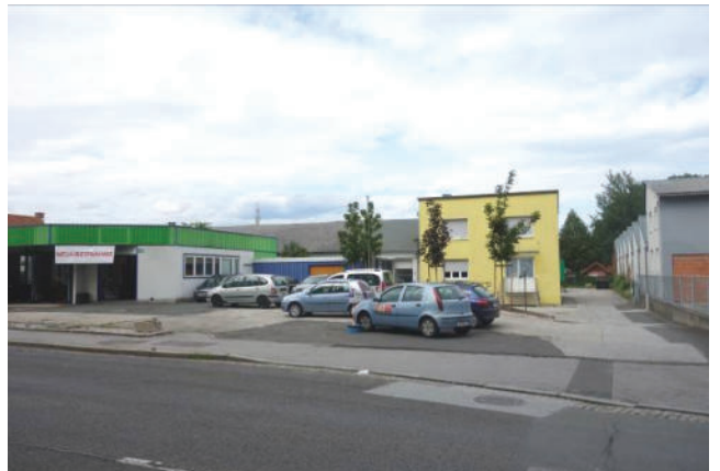
Foto 6: Blick in nordöstliche Richtung von der Wiener Straße auf die Liegenschaft Wiener Straße 206 (gelbes zweigeschossiges Gebäude)
