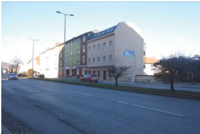
Foto 5: Blick in nördliche Richtung von der Schleifbachgasse auf die Bebauung an der Wiener Straße nördlich der Liegenschaft Wiener Straße 208
