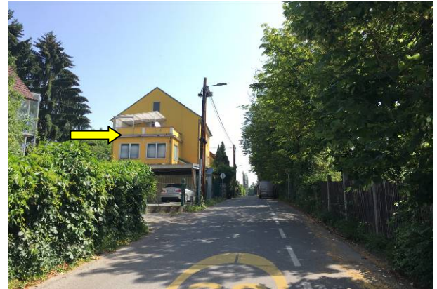
Foto 2: Blick in nordöstliche Richtung entlang der Lortzinggasse. Der gelbe Pfeil markiert das Wohngebäude „Lortzinggasse 5“.
