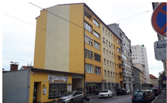
Foto 4: Idlhofgasse 107, 111, 117: Blick Richtung Süden
