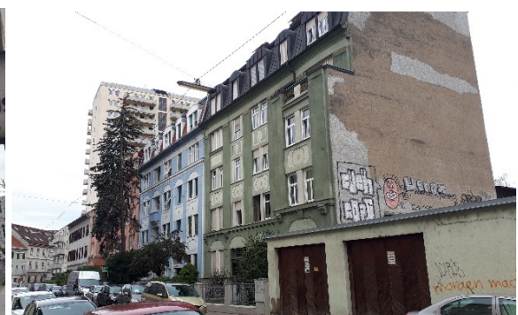
Foto 6: Kindermannngasse 32, 34, 36 im Hintergrund Hochhaus Lazarettgasse 18 Blick Richtung Süden
