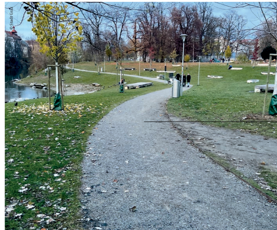
Versickerungsfähige Gehwegoberfläche Augartenpark
