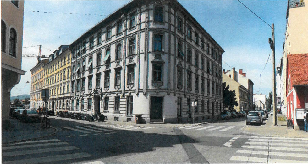
Foto 1: Blick in nordwestliche Richtung im Kreuzungsbereich Lagergasse – Hermann-Bahr- Gasse.
