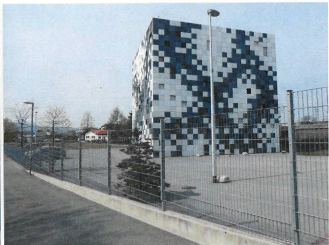
Foto 4: Blick in nordwestliche Richtung auf den Kubus der Firma Prisma Engineering Maschinen- und Motorentechnik GmbH, Liebenauer Hauptstraße 82c im Gewerbegebiet, nördlich des Petersbaches und damit nördlich des Bebauungsplangebietes
