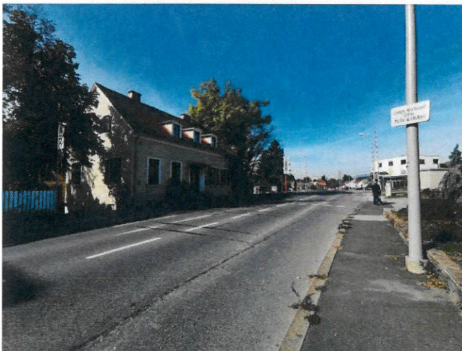
Foto 7: Blick in nordwestliche Richtung entlang der Liebenauer Hauptstraße, links im Bild das Gebäude der Liegenschaft Liebenauer Hauptstraße 84, dahinter die Gleisanlage der ÖBB. Zukünftig soll diese Straße unterirdisch geführt werden
