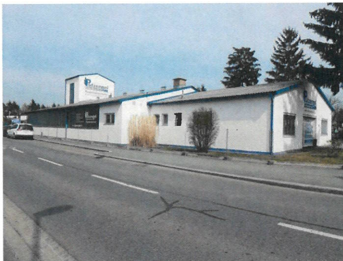
Foto 16: Blick in nordöstliche Richtung auf die eingeschossigen Hallenbauten sowie ein turmartiges Gebäude einer Reinigungsfirma an der Puntigamer Straße 14
