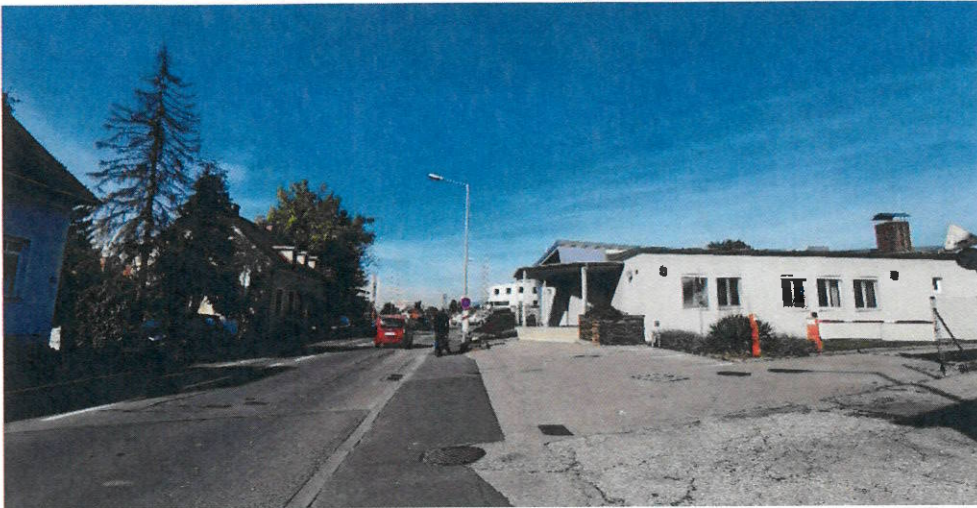
Foto 2: Blick in nördliche Richtung vom Bereich Kreuzung Liebenauer Hauptstraße / S-Bahn / unterirdische Verrohrung Petersbach. Rechts im Bild ist das eingeschossige Gebäude der Polizeiinspektion Graz – Liebenau zu sehen. Zukünftig wird die Liebenauer Hauptstraße in diesem Bereich unterirdisch geführt
