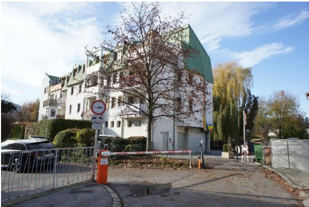
Blick auf die straßenabgewandte Bebauung Andritzer Reichsstraße 37c, 37d. Blick Richtung: Westen.
