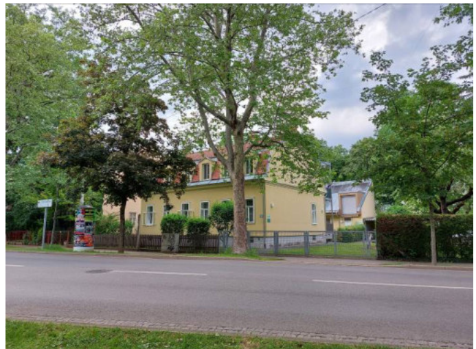
Foto 2: Blick in nördliche Richtung entlang der Eggenberger Allee Höhe Hausnr. 60 u. 60 a.
