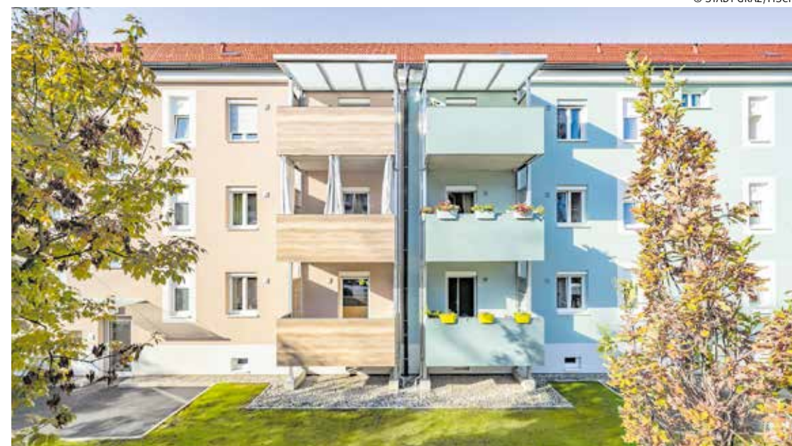
Auf der Tändelwiese. 132 Wohneinheiten wurden hier bereits thermisch saniert und neue Balkone zugebaut.
