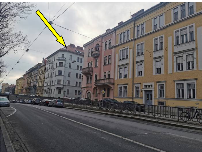
Foto 8: Blick in südliche Richtung auf die vier- bzw. fünfgeschossige Bebauung (Lendkai 73, siehe Pfeil) am Lendkai. Fotostandort ca. auf Höhe Lendkai 77 (rechts im Bild das Gebäude mit der gelben Fassade)
