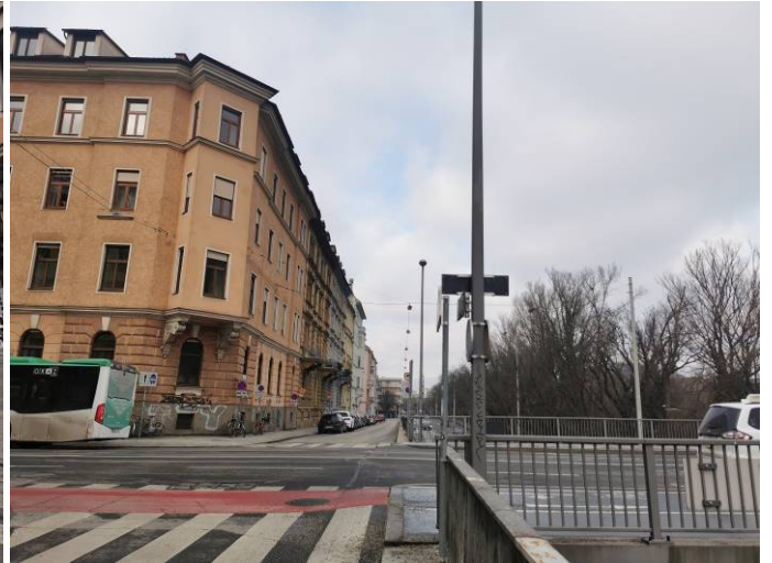
Foto 5: Blick in nordwestliche Richtung entlang des Lendkai auf die Blockrandbebauung des gegenständlichen Bebauungsplangebiets Ecke Keplerstraße / Lendkai
