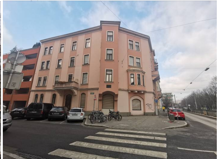
Foto 7: Blick in nordwestliche Richtung auf die Eckbebauung im Blockrandverbund Netzgasse 11
