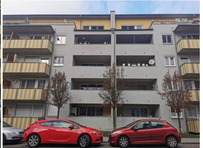
Foto 23: Blick in nordwestliche Richtung auf die Wohnbebauung Netzgasse 7
