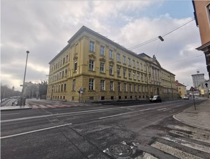
Foto 4: Blick in südwestliche Richtung auf das Gebäude des Keplergymnasiums Ecke Keplerstraße / Lendkai
