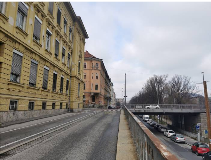
Foto 30: Blick in nordwestliche Richtung entlang des Lendkai, rechts ist die Keplerbrücke zu sehen, links das Gebäude des Keplergymnasiums
