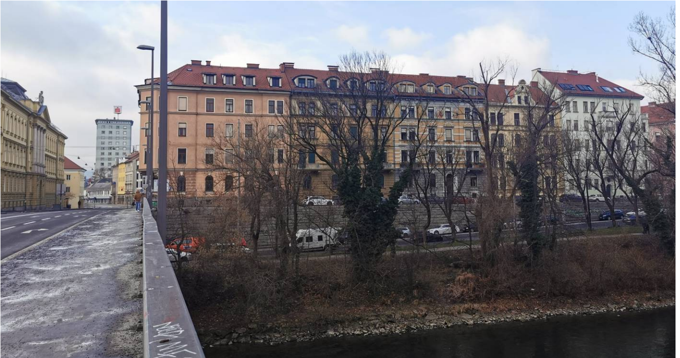
Foto 1: Blick in südwestliche Richtung von der Keplerbrücke auf die Blockrandbebauung entlang des Lendkai nördlich der Keplerstraße im gegenständlichen Bebauungsplangebiet. Ganz links im Bild ist die straßenraumbildende Bebauung des Gymnasium Kepler zu sehen
