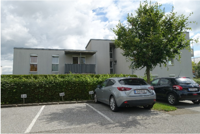
Foto 15: Blick in östliche Richtung auf den Wohnbau Gaisbacherweg 2
