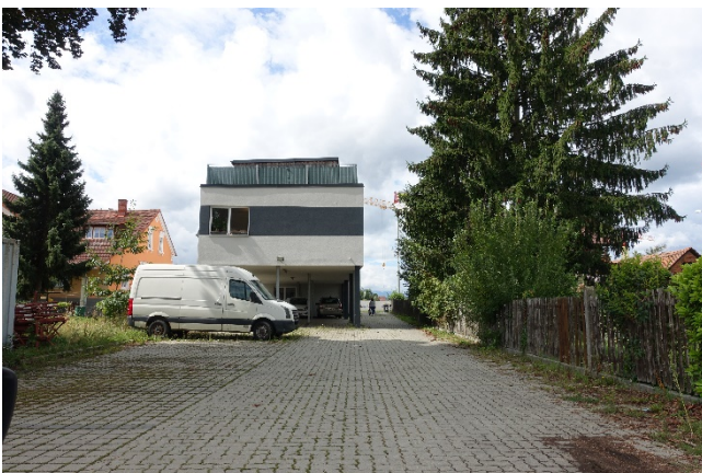
Foto 17: Blick in südwestliche Richtung auf die Liegenschaft Triester Straße 447, ein Gebäude mit gewerblicher Nutzung vom Feldkirchner Weg aus gesehen
