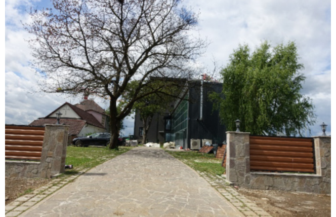
Foto 14: Blick in südwestliche Richtung auf die Liegenschaft Triester Straße 439 mit einer Hotelnutzung
