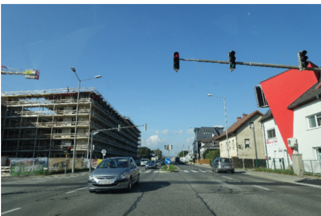
Foto 41: Blick in nordwestliche Richtung, links zweigt die Grenzgasse nach Westen ab, nördlich befindet sich ein Geschossbau (in Bau), rechts ist die Bebauung entlang der östlichen Straßenseite der Triester Straße zu sehen (Liegenschaften Triester Straße 449 bis 439) im gegenständlichen Bebauungsplangebiet
