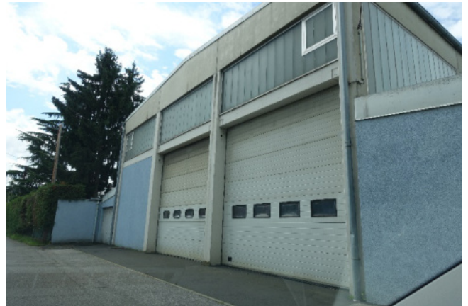
Foto 10: Blick in südwestliche Richtung auf die Liegenschaft Triester Straße 423, ein Karosseriebauunternehmen
