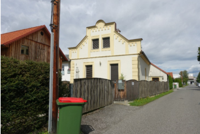
Foto 7: Blick in nördliche Richtung entlang des Feldkirchner Weges auf die Liegenschaft Feldkirchner Weg 42
