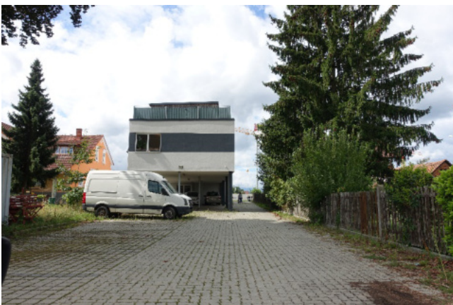
Foto 17: Blick in südwestliche Richtung auf die Liegenschaft Triester Straße 447, ein Gebäude mit gewerblicher Nutzung vom Feldkirchner Weg aus gesehen
