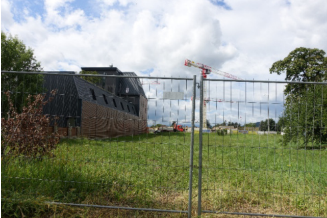
Foto 13: Blick in westliche Richtung auf ein unbebautes Grundstück, im Hintergrund ist eine Baustelle an der Triester Straße/Grenzgasse für einen künftigen Geschosswohnbau zu sehen
