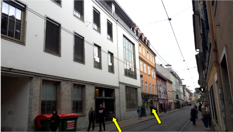
Foto 12: Jakoministraße: Blick Richtung Süden: Gelbe Pfeile zeigen auf Jakoministraße 5 und 7
