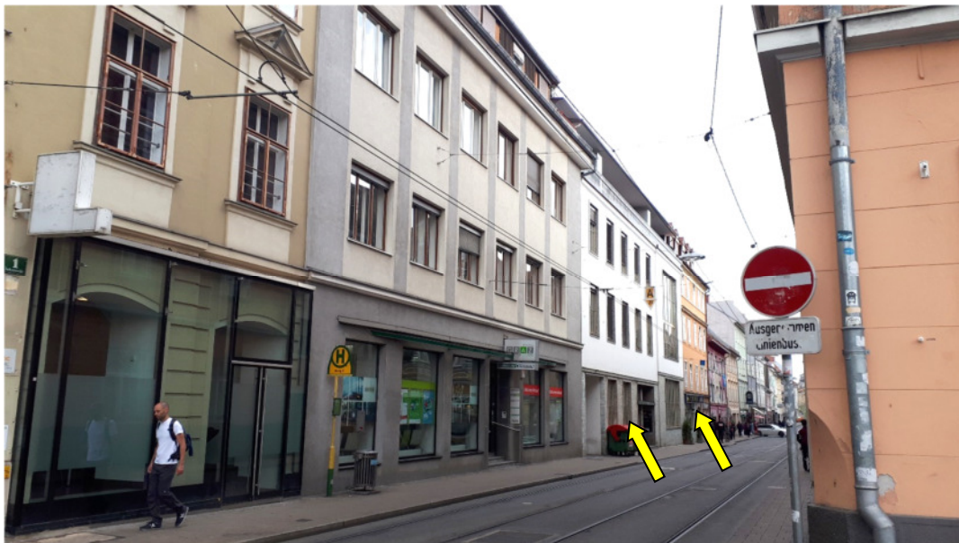
Foto 11: Jakominisstraße: Blick Richtung Süden: Gelbe Pfeile zeigen auf Jakoministraße 5 und 7
