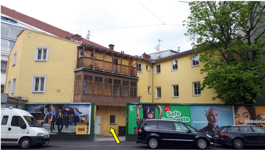
Foto 10: Grazbachgasse: Blick Richtung Nor- den: Gelber Pfeil zeigt auf Grazbachgasse 38
