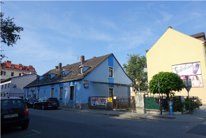
Foto 2: Blick in südwestliche Richtung auf die Bebauung Vinzenzgasse 41 (rechts) / Lerchengasse 3 südlich des Bebauungsplangebiets
