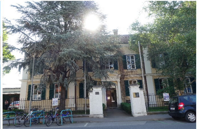
Foto 5: Blick in östliche Richtung auf das Pfarrhaus St. Vinzenz
