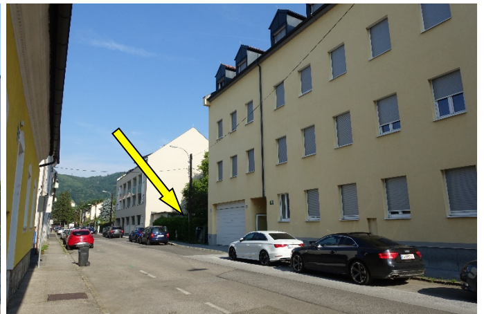
Foto 7: Blick in nordwestliche Richtung auf die Wohnhäuser Lerchengasse 10 (rechts im Bild) und Lerchengasse 16 (in Bildmitte). Dazwischen befindet sich ein Bauplatz mit einem hofseitigen Einfamilienhaus (Bauplatz siehe Pfeil)
