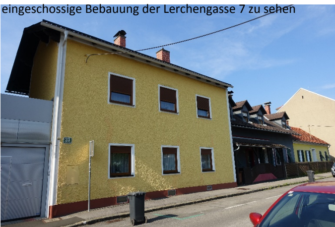
Foto 12: Blick in südwestliche Richtung auf die Bebauung der Lerchengasse 23
