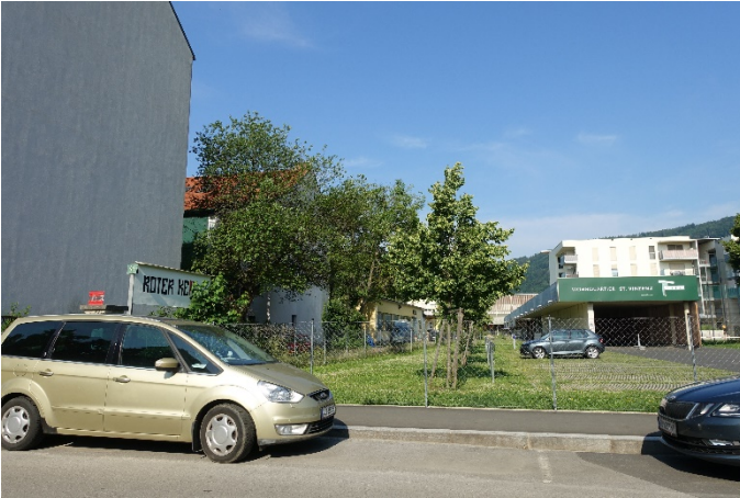
Foto 26: Blick in westliche Richtung auf die TG-Einfahrt des „Wohnquartiers St. Vinzenz“, links davon das Wohngebäude Vinzenzgasse 47 mit dem dahinterliegenden Wohngebäude Vinzenzgasse 47a
