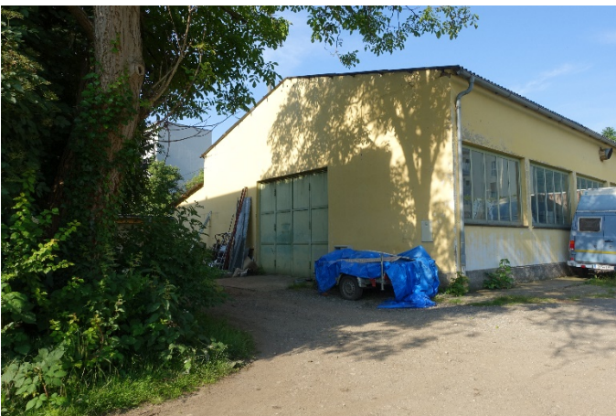
Foto 28: Blick in südwestliche Richtung auf das Lagergebäude der Liegenschaft Vinzenzgasse 49
