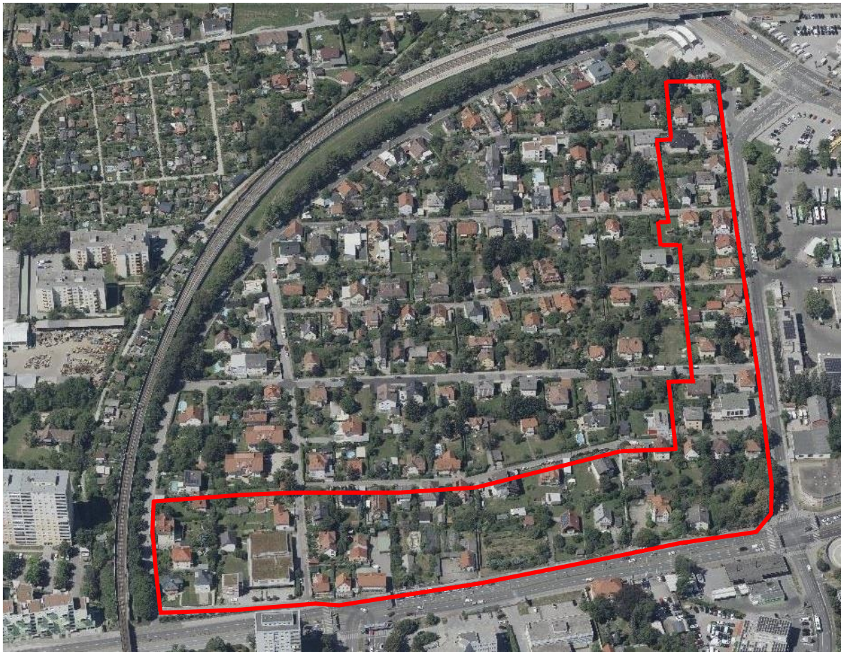
Schrägluftbild (2022): Auszug aus dem Geo-Daten-Graz. (BW_30_3399) © Stadtvermessung Graz. Blick Richtung Westen. Die rote Umrandung markiert die ungefähre Lage des Planungsgebietes.
