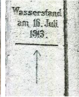
Am Herz-Jesu-Pfarrgebäude wurde der Wasserhöchststand dokumentiert.
