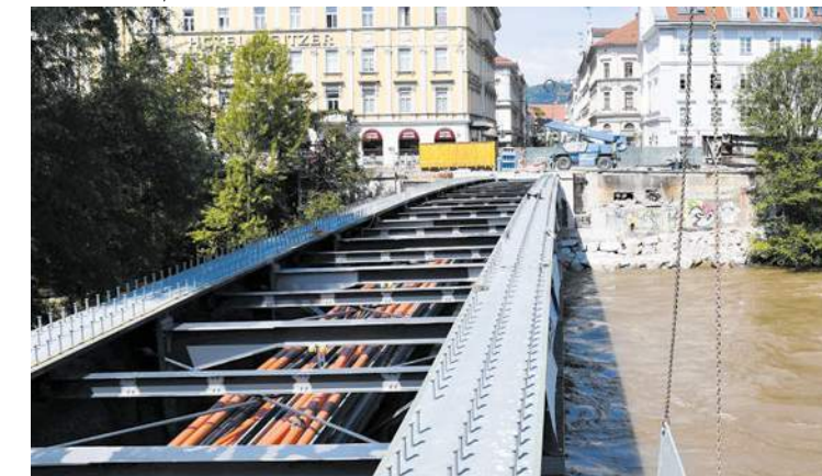
Millimeterarbeit. Mitte Juli wird das noch fehlende nördliche Tandem der Tegetthoffbrücke eingehoben. Beim südlichen Tandem (siehe Foto oben) ist dies bereits geschehen.
