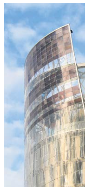
Science Tower. Architektonischer Leuchtturm in der Smart City.
