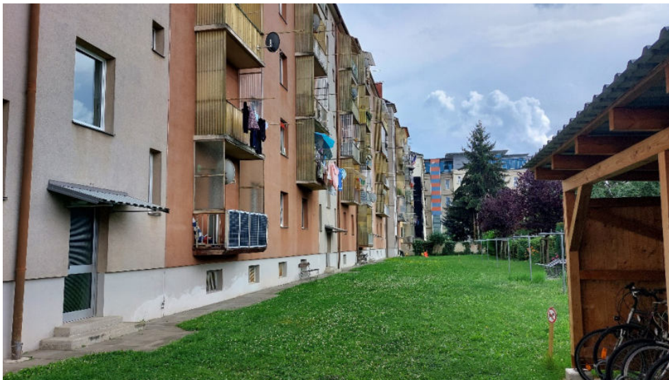
Foto 17: Blick in südliche Richtung aus dem hofseitig gelegenen Freibereich der Häuser Gabelsbergerstraße 7 - 13.
