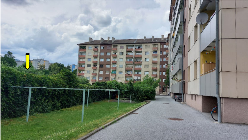
Foto 16: Blick in nördliche Richtung aus dem hofseitig gelegenen Freibereich der Häuser Gabelsbergerstraße 15 - 17.
