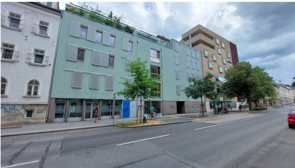
Foto 2: Blick in südliche Richtung an der Keplerstraße 74.
