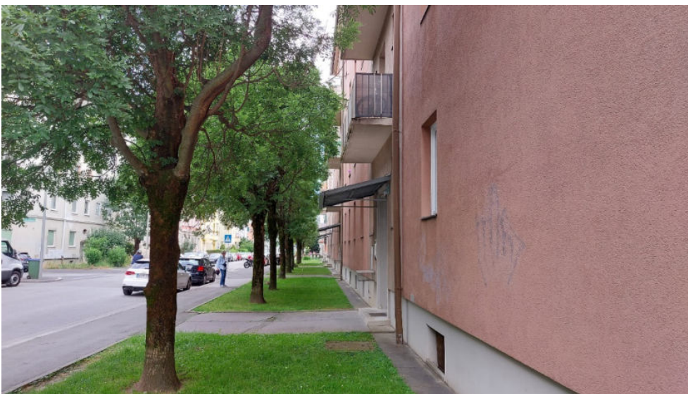
Foto 15: Blick in südliche Richtung entlang der Gabelsbergerstraße auf Höhe Hausnummer 13.
