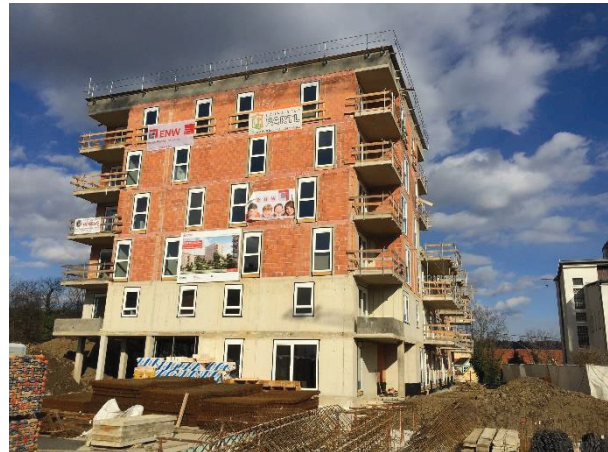
Abbildung 15: Rohbau Neubauvorhaben Am Mühlriegel © Wohnen Graz
