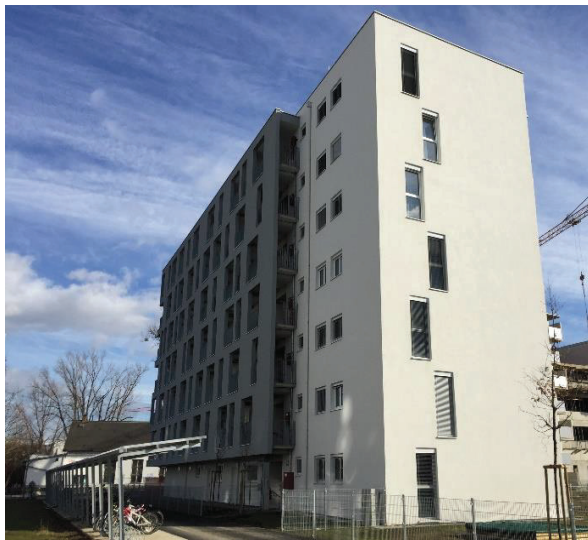
Abbildung 11: Neubauprojekt Waagner-Biro-Straße 49, 49a © Wohnen Graz
