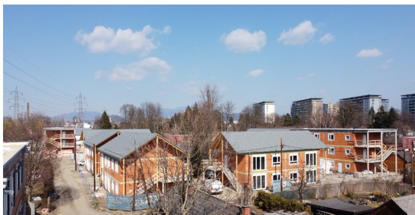
Abbildung 14: Aktueller Baufortschritt Neubauvorhaben Am Grünanger © Bauunternehmung Granit GmbH
