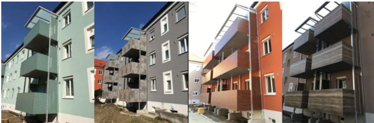
Abbildung 59: Thermische Sanierung in der Triester-Siedlung © Wohnen Graz
