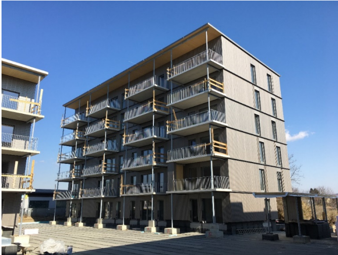
Abbildung 17: Übertragungswohnbau Zieherstraße in Holzbauweise © Wohnen Graz
