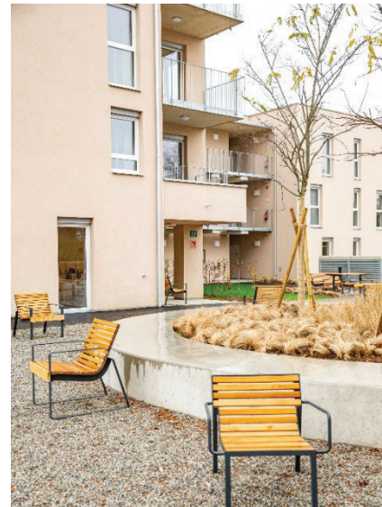
Abbildung 22: Übertragungswohnbau Am Mühlriegel © Foto Fischer
