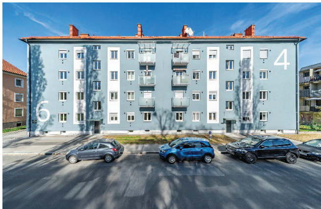
Abbildung 26: Thermisch sanierte WEG Auf der Tändelwiese 4, 6 © Foto Fischer
