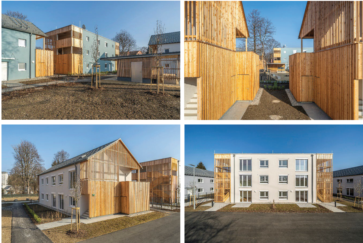
Abbildung 15-18: Das zweite Eigeneubauprojekt des Eigenbetriebes Wohnen Graz © Foto Fischer
