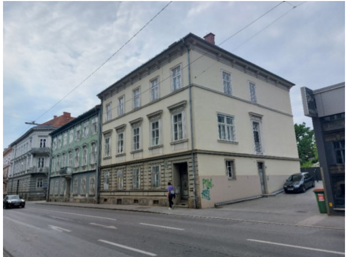
Foto 12: Blick in südliche Richtung entlang der Merangasse Höhe Hausnr. 36.
