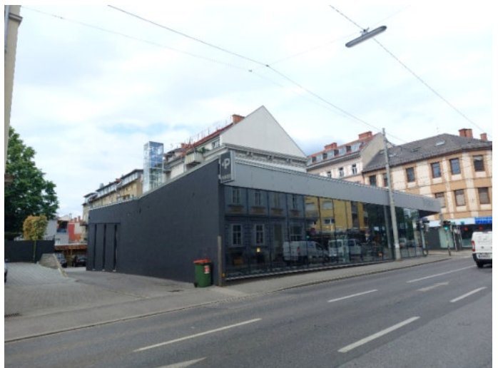
Foto 14: Blick in westliche Richtung entlang der Merangasse Höhe Hausnr. 32. Eingeschossige, moderne Eckverbauung mit Glasfassade und Flugdach.
