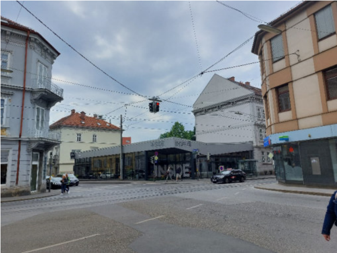
Foto 15: Blick in südliche Richtung im Kreuzungsbereich Leonhardstraße / Merangasse mit Blick auf das Bebauungsplangebiet.
