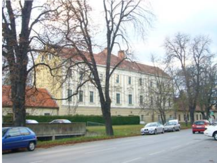
Foto 6: Bestandsobjekt an der Kasernstraße (unter Denkmalschutz)
