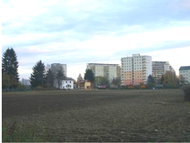
Foto 2: Wohnbebauungen hoher Dichte
