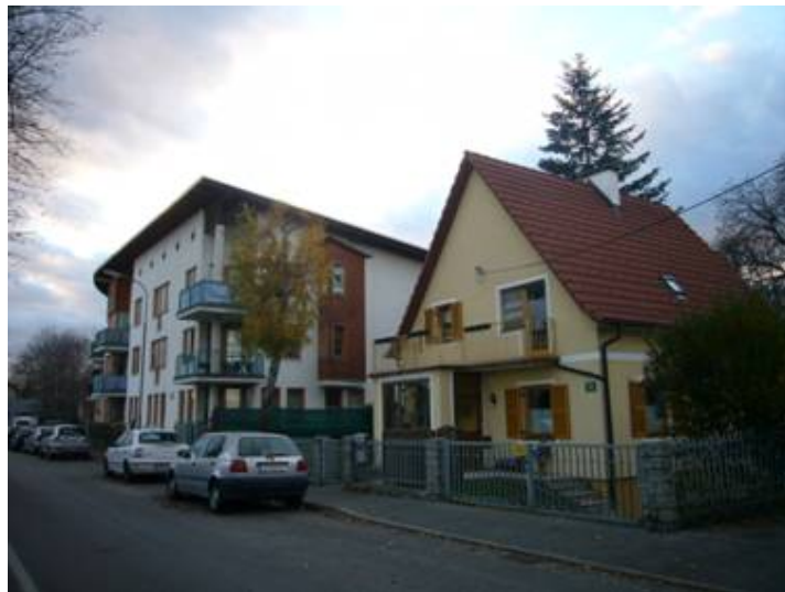
Foto 1: Trattenweg Blickrichtung Nordwesten
