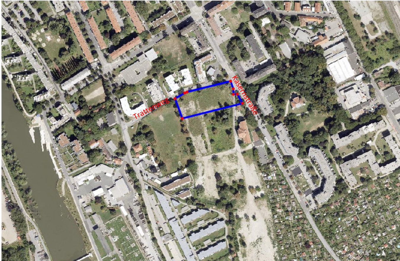
Luftbild der Stadt Graz/Stadtvermessung. Der blaue Rahmen kennzeichnet das Bauungsplangebiet.
