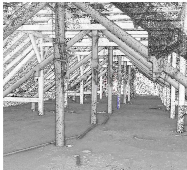
Laserepunktewolke | Dachstuhl TenneTennelerei | STADTVERMESSUNG ©
