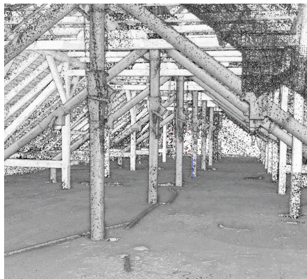
Laserpunktwolke | Dachstuhl Tenmenmelzerei | STADTVERMESSUNG ©
