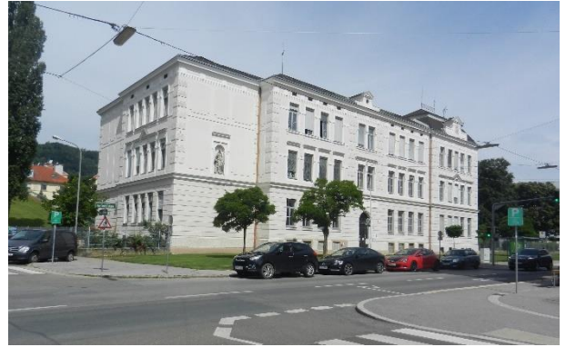
Abbildung 2: Kreuzung Seidenhofstraße/Karl-Morre-Straße Blick Richtung Nordwesten
