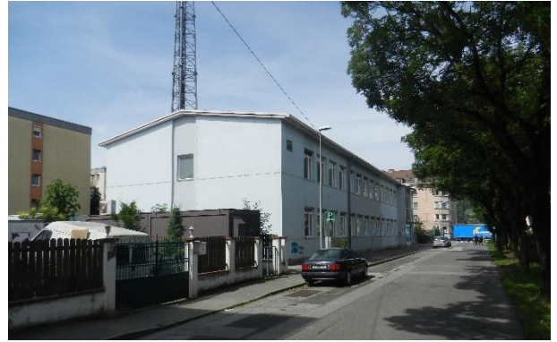
Abbildung 10: Blick auf die Bebauung Königshoferstraße 33 in Richtung Südwesten
