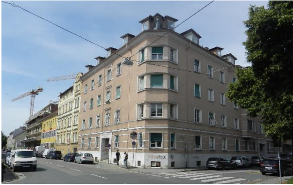
Abbildung 13: Kreuzung Karl-Morre-Straße/Königshoferstraße Blick Richtung Südwesten
