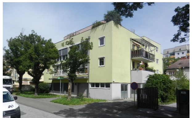
Abbildung 24: Blick auf die Bebauung Königshoferstraße 40 in Richtung Nordwesten.
