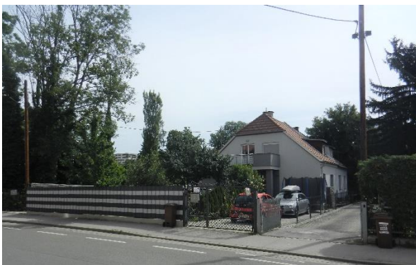
Abbildung 7: Blick auf die Bebauung Gaswerkstraße 41a und 43 in Richtung Nordosten
