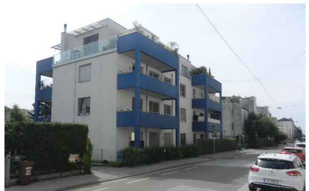
Abbildung 8: Blick entlang der Gaswerkstraße Höhe 38 in Richtung Südosten
