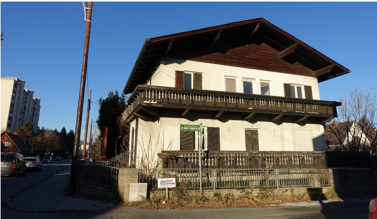
Foto 10: Blick in nördliche Richtung, rechts das Wohnhaus Straßganger Straße 209, links im Hintergrund die 11-geschossigen Wohnbauten der Straßganger Straße 210, 210a
