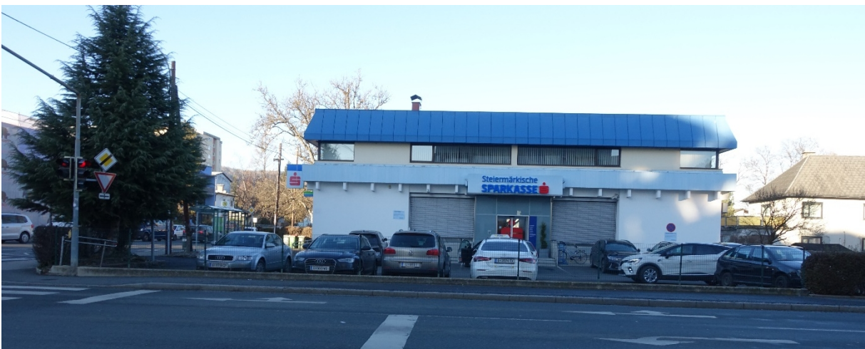
Foto 3: Blick in nordöstliche Richtung von der Liegenschaft Straßganger Straße 205 auf das zweigeschossige Gebäude der Liegenschaft Straßganger Straße 195, diese wird als Bankfiliale genutzt. Die Liegenschaft befindet sich im nördlichen Kreuzungsbereich Straßganger Straße / Peter-Rosegger-Straße
