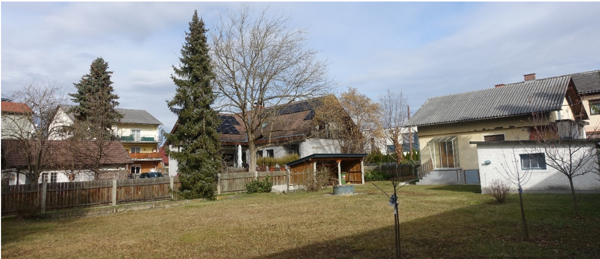
Foto 22: Blick in nordöstliche Richtung, rechts die Liegenschaft Fasanstraße 32, links davon die Fasanstraße 30
