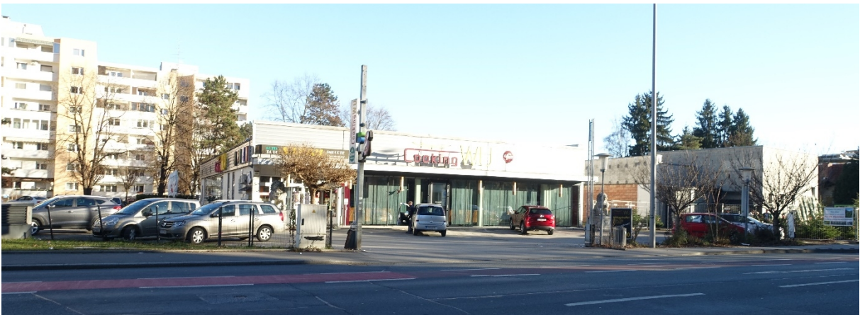
Foto 2: Blick in südöstliche Richtung auf das eingeschossige Gebäude der Liegenschaft Straßganger Straße 207, nördlich des Bebauungsplangebietes mit einer Nutzung für einen Gastronomiebetrieb
