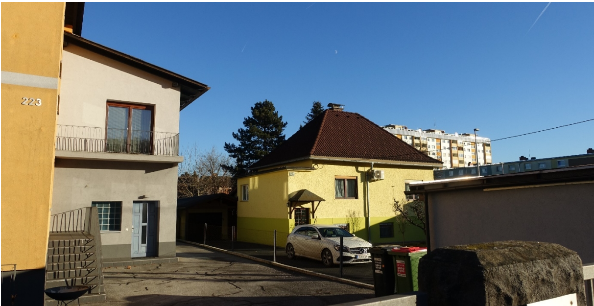
Foto 17: Blick in südöstliche Richtung, links ist die Liegenschaft Straßganger Straße 223, rechts die Liegenschaft Straßganger Straße 225 zu sehen
