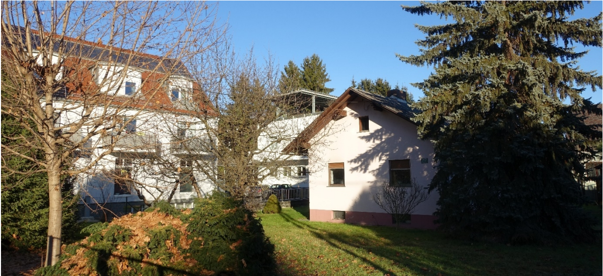
Foto 9: Blick in nordöstliche Richtung auf die Liegenschaft Straßganger Straße 217
