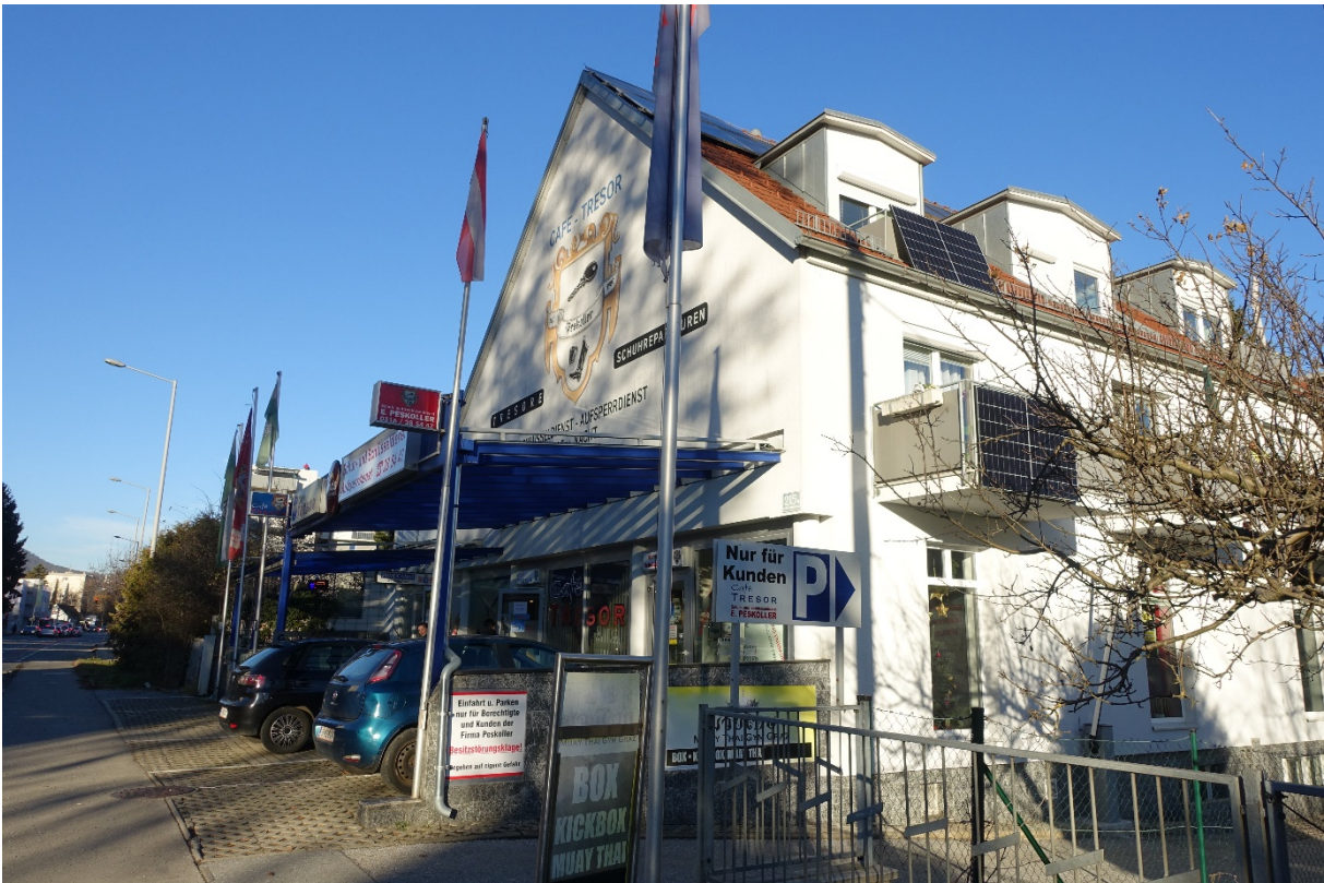
Foto 8: Blick in nordöstliche Richtung auf das Gebäude an der Straßganger Straße 213 mit Nutzungen für Dienstleistungen sowie augenscheinlich Wohnen in den oberen Geschossen
