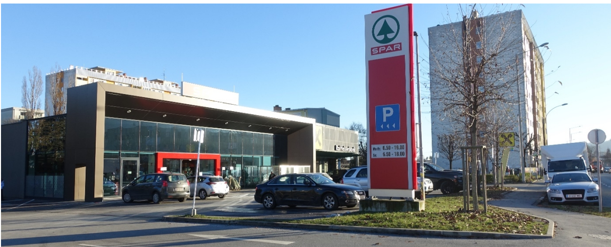
Foto 18: Blick in südöstliche Richtung, im Vordergrund ist die Liegenschaft Straßganger Straße 229 mit dem Supermarkt zu sehen, rechts im Bild der 10-geschossige Wohnbau Grottenhofstraße 90 und 92
