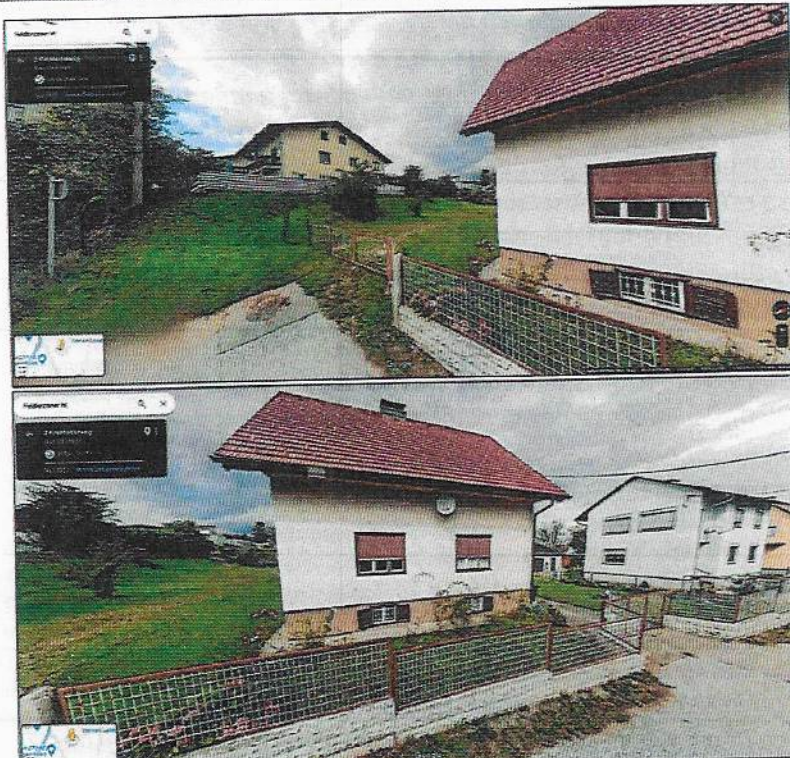
Abbildung 4 - Blick in Richtung Bebauungsplangebiet vom Kirchfelderweg aus mit Blick auf Böschung
