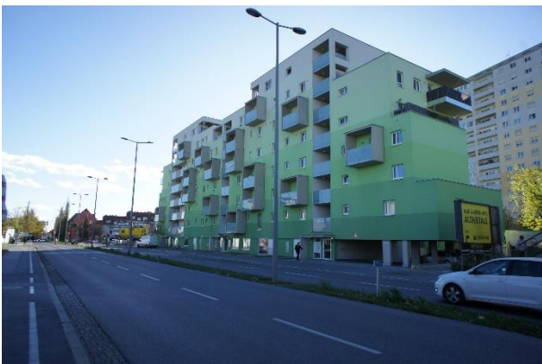
Blick in den Lazarettgürtel auf Höhe der Eisenbahnbrücke. Blick Richtung Südwesten.
