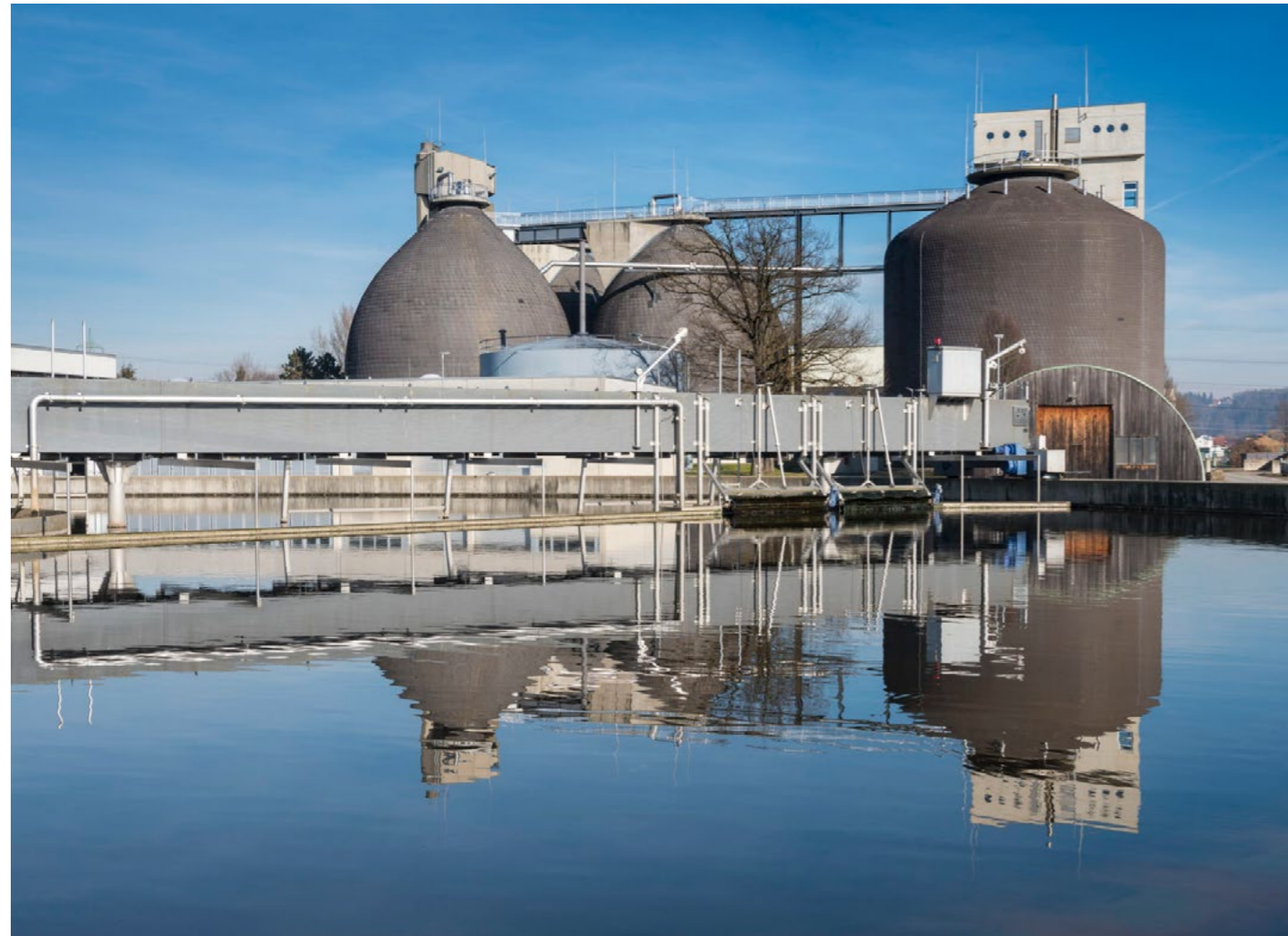
Kläranlage Stadt Graz.
