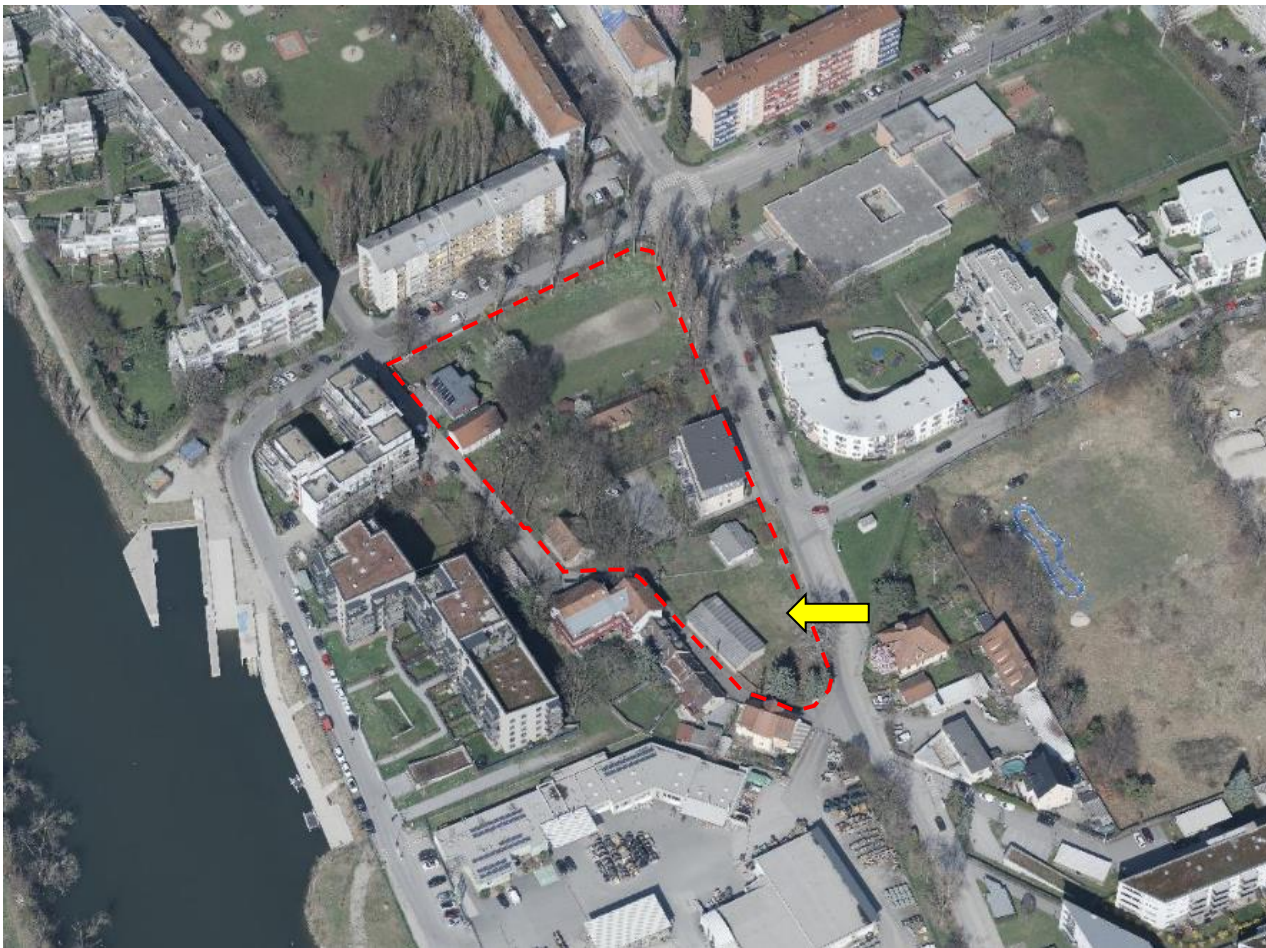
Die rot strichlierte Umrandung kennzeichnet das Bebauungsplangebiet, Blick in nördliche Richtung. Der gelbe Pfeil markiert das Grundstück des Antragstellers (Mühlgangweg 11).
