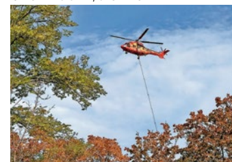
Heli-Einsatz. Sanierung der Brücke über die Schloßbergbahn.
