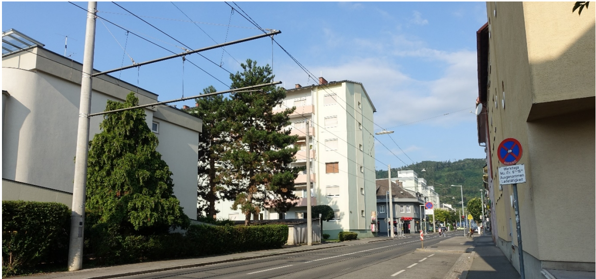
Foto 5: Blick in südwestliche Richtung auf Höhe Georgigasse 24, links im Vordergrund ist die Wohnbebauung Georgigasse 21 zu sehen, dahinter der 6-geschossige Wohnbau Vinzenzgasse 22
