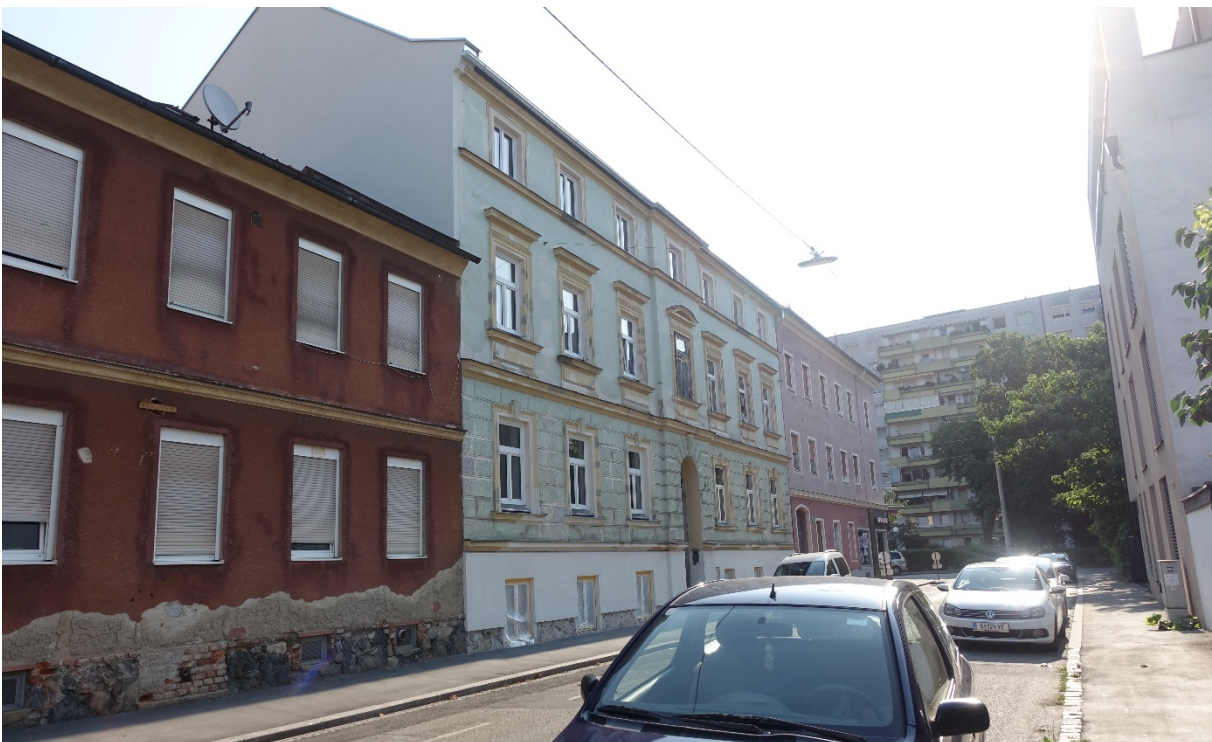
Foto 17: Blick in nordöstliche Richtung, links sind die Liegenschaften Rochelgasse 2, 4 und 6 (von rechts nach links) zu sehen
