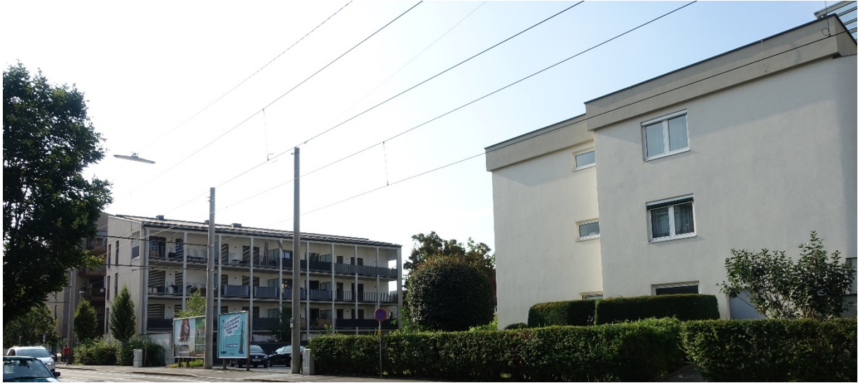
Foto 4: Blick in südöstliche Richtung auf Höhe Georgigasse 24 auf den 4-geschossigen Wohnbau der Prangelgasse 25, nordwestlich des gegenständlichen Bebauungsplangebiets
