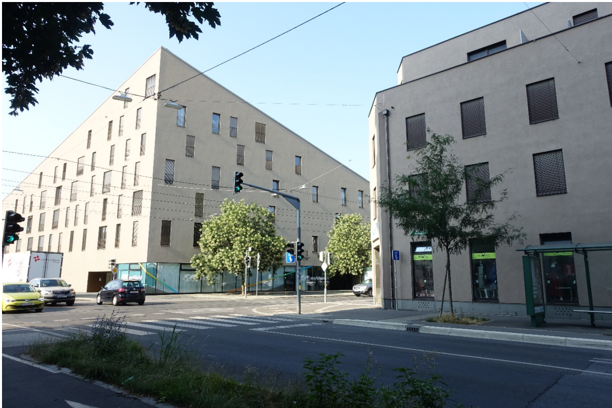
Foto 1: Blick in südwestliche Richtung auf das mehrgeschossigen Wohn- und Geschäftshaus der Liegenschaft Georgigasse 1 – 7 bzw. Alte Poststraße 122, 124 südlich des gegenständlichen Bebauungsplangebietes. Rechts im Bild ist die 2-geschossige Bebauung mit Penthouse, Georgigasse 2, im Gebiet des Bebauungsplangebietes zu sehen
