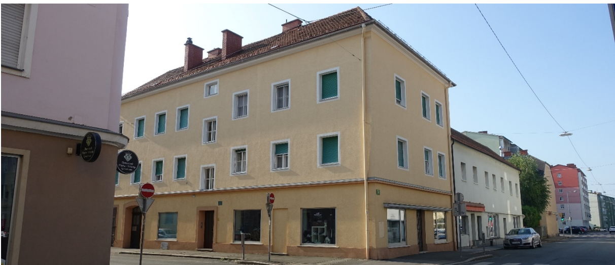
Foto 10: Blick in südöstliche Richtung, in Bildmitte ist das dreigeschossige Eckgebäude der Liegenschaft Vinzenzgasse 30 bzw. Rochelgasse 23 zu sehen
