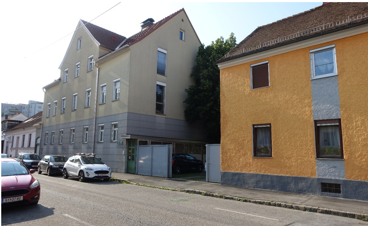
Foto 13: Blick in südöstliche Richtung auf das Wohnhaus der Rochelgasse 11, rechts im Vordergrund befindet sich die Rochelgasse 13
