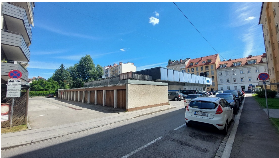
Foto 9: Blick in westliche Richtung aus dem Kreuzungsbereich Schönaugasse - Nordweg;
