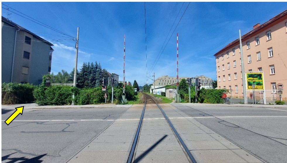
Foto 1: Blick in westliche Richtung vom Bahnübergang der Ostbahnstrecke - Schönaugasse aus;
